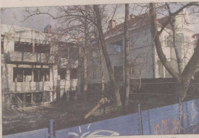
Właśnie powstaje łącznik pomiędzy dwiema zabudowlami kamienicami we Wrzeszczu. Wszystkie budynki zajmie WSA.
