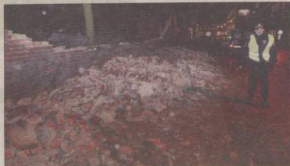
O włos od tragedii. Przewracający się mur przy ul. Gnilnej w Gdańsku przyniósł kobietę.
