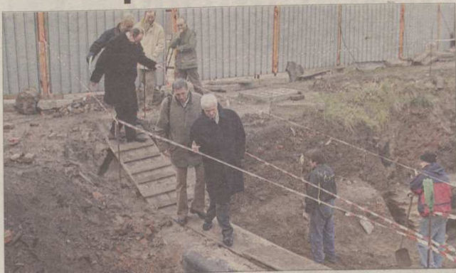
Na razie odkryto fundamenty i gotyckie mury teatru elżbietańskiego. Oglądali je gdańscy władze. Wkrótce stanie tu nowoczesny teatr.
