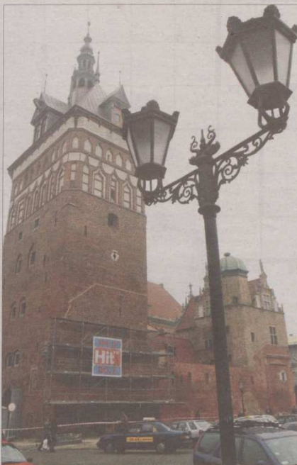
Tak wygląda wieża więzienna po remoncie.
