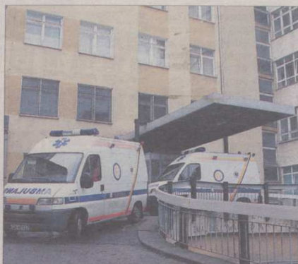
W Szpitalu Miejskim zmiany najbardziej widoczne będą przy podjeździe dla karet, od strony ul. Starowiejskiej
