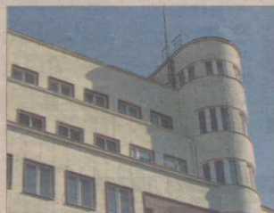
Dzięki dotacjom miasta wyremontowany m.in. elewację budynku wspólnoty mieszkaniowej „Bankowiec” u zbiegu ulic 10 lutego i 3 maja.
