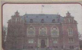
Remont budynku nowego ratusza w centrum Gdańska ul. Wały Jagiellońskie (odrestaurowano historyczny budynek główny, wozownię, mur okalający budynek, oraz zagospodarowano teren. Zakup całego wyposażenia wnętrza). Całkowity koszt: 13,7 mln zł
