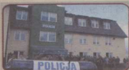
Budowa Komisariatu Gdańsk Południe (Obiekt piętrowy o powierzchni użytkowej 1,625 m.kw. z użytkowym poddaszem. W piwnicy, oprócz magazynów i siłowni, urządzono 4-torową strzelnicę. Komisariat przystosowano dla potrzeb osób niepełnosprawnych. Utworzono również stanowisko monitorowania osiedla mieszkanego). Całkowity koszt: 4 mln zł
