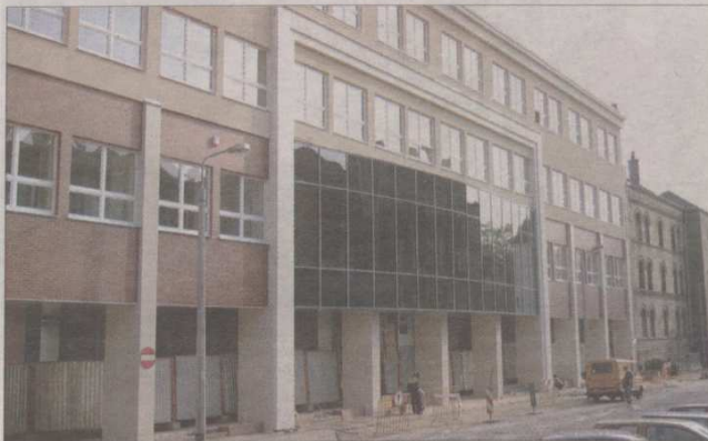
Jak na razie przyszła siedziba Pierwszego Urzędu Skarbowego wygląda zupełnie normalnie. Czy blisko 13 mln zł zmieni dawny budynek zakładów Unimor w pałac? Fot. Grzegorz Mehlberg
