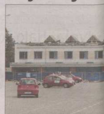
Jutro ośrodek przy ul. Równiej zostanie otwarty.
