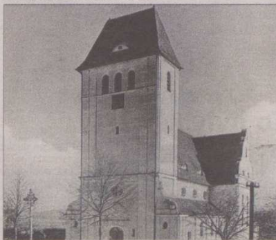
Kościół p.w. św. Krzyża, z którego Niemcy na początku okupacji usunęli wieżyczkę, uniemożliwiając ewentualną obserwację pobliskiego lotniska. Pocztówka z roku 1941.
