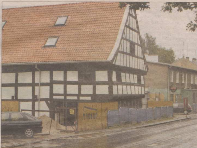
Remont dworu zakończy się w grudniu br. Na razie zamieszka w nim właściciel, a w przyszłym roku ruszą prace nad karczmą.
