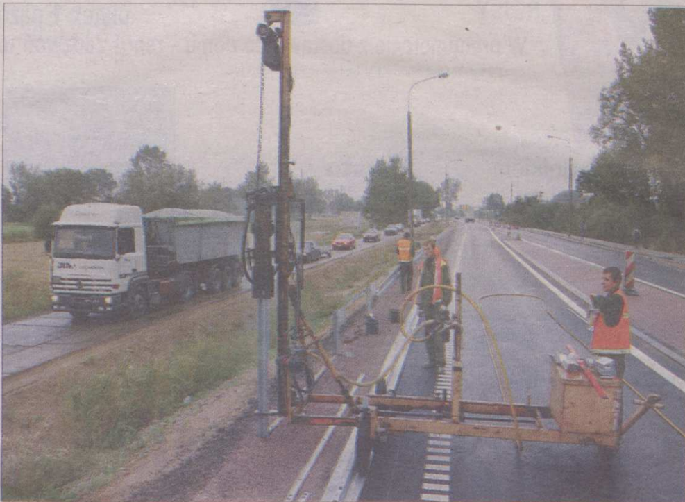
Wyjazd z Gdańska w kierunku Warszawy (środa godz. 11). Remont tej drogi ciągnie się jak przerywana linia przy poboczu. Malowanie drogi wróży jednak rychły koniec prac, choć kierowcy pamiętają „malowany” most w Kiezmorku (na tej samej trasie), który znów jest w remoncie.
