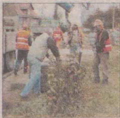
Trwa remont drogi nr 221 w Kolbudach.
