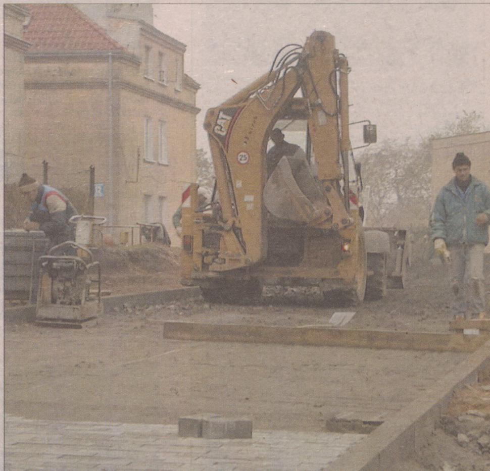
Po wykopaniu niewybuchów i sprawdzeniu całej drogi, praca na ul. Chełmońskiego wrę.
