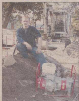
Adam Pleszewicz układa nowy kabel.
