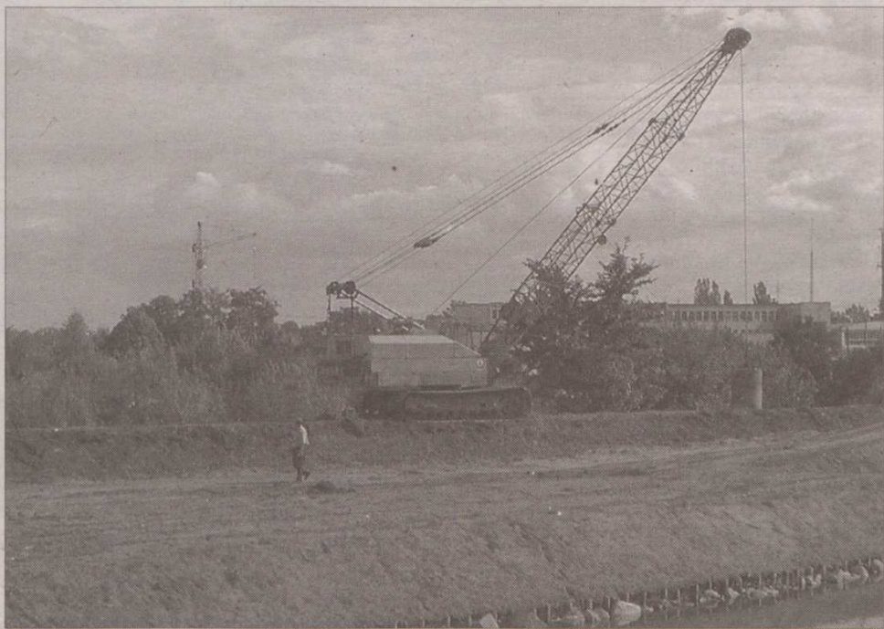
Ciężki dźwig zagęszcza koronę wału przeciwpowodziowego na rogatkach Pruszcza.
