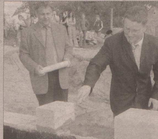
Lech i Remigiusz Modrzyńscy, wmurowali akt erekcyjny pod centrum biznesu w Straszynie, gdzie pracę ma znaleźć 300 osób.
