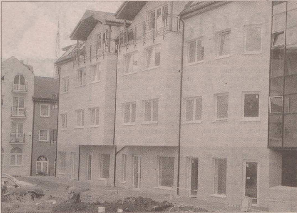
Puszczanie, którzy kupili mieszkania w bloku przy ul. Kossaka 6 już dwa lata czekają na odbiór budynku.
