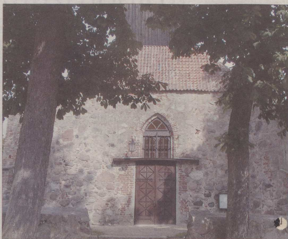
Zbudowany z otoczków gotycki kościół w Pręgowie, to wyjątkowo cenny obiekt.
