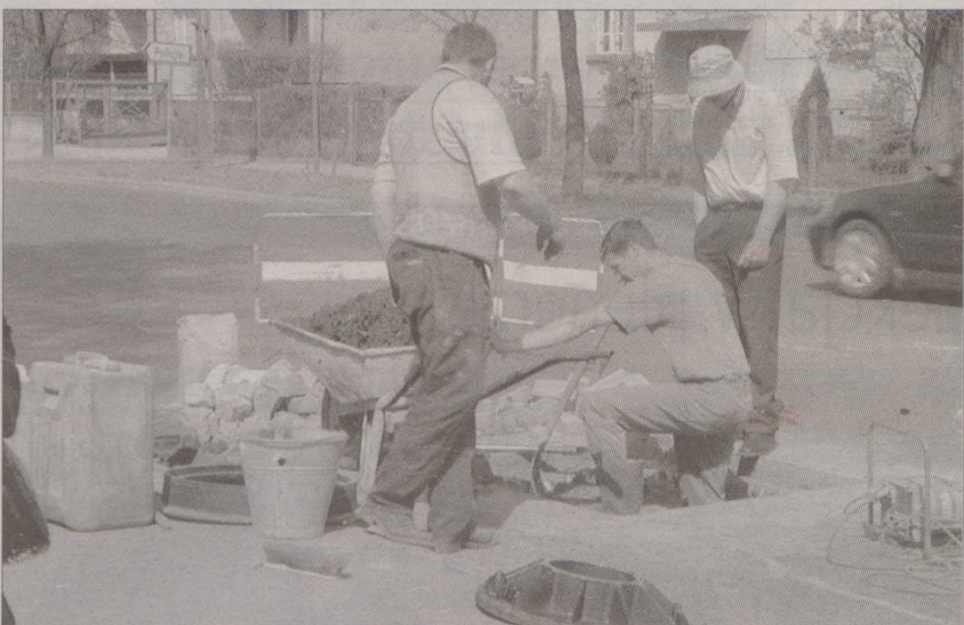
W Pruszczu wyremontowano studzienki drogowe.
