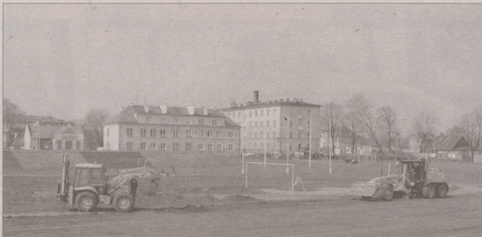
Na stadionie MOSiR trwają intensywne prace.
