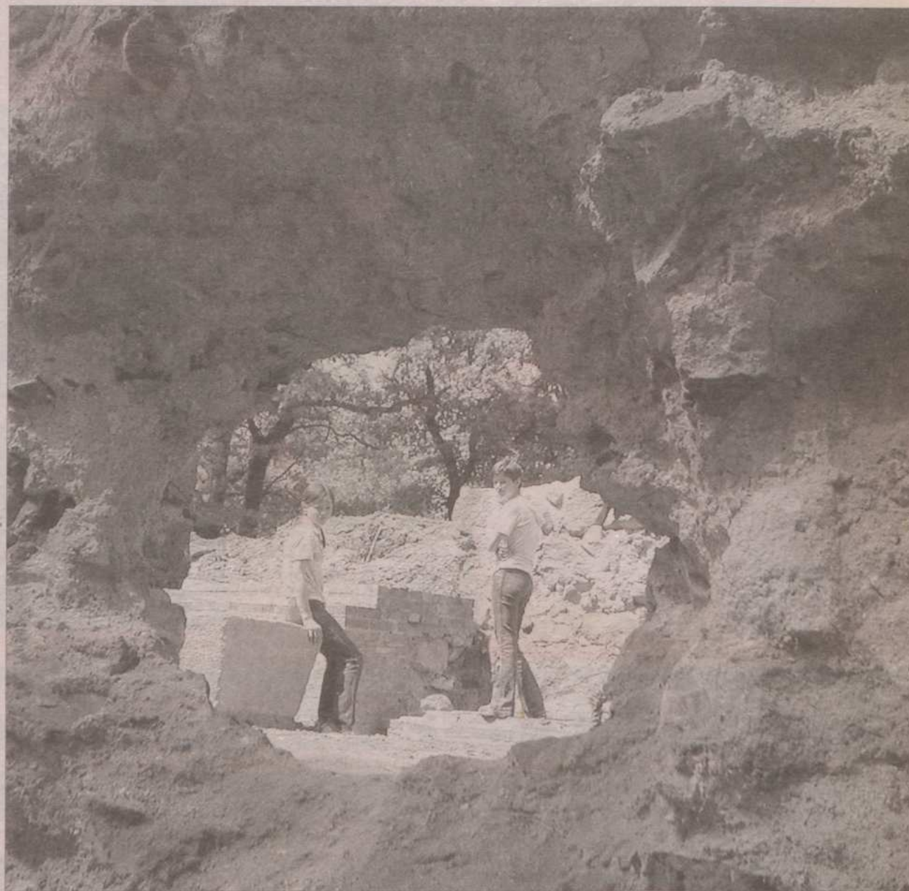
Zgodnie z drugim etapem programu rozpoczęto wymurowywanie odkrytych reliktów do poziomu bruku zamkowego dziedzińca.
