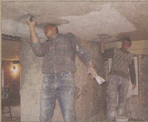
Marcin Hermaniuk maluje sufit wyremontowanej piwnicy.
