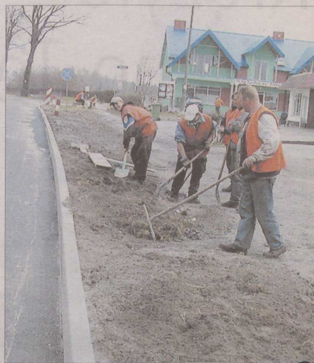
Remont drogi w Czerninie trwa.
