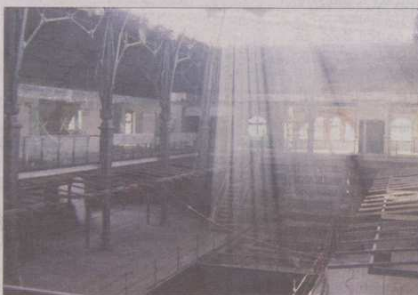
Kupcom nie udało się z bankami. Czy miasto pożyczycie 1 mln zł na dokończenie prac remontowych hali targowej?
