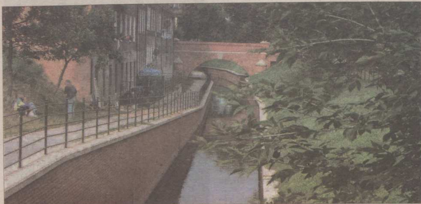
Modernizacja Kanału Raduni kosztowała miasto dotąd 10,7 mln zł. Na remont obiektu na całej jego długości trzeba by wydać około 150 mln zł.
