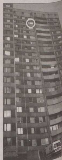
Kobieta wypadła przez to okno.
