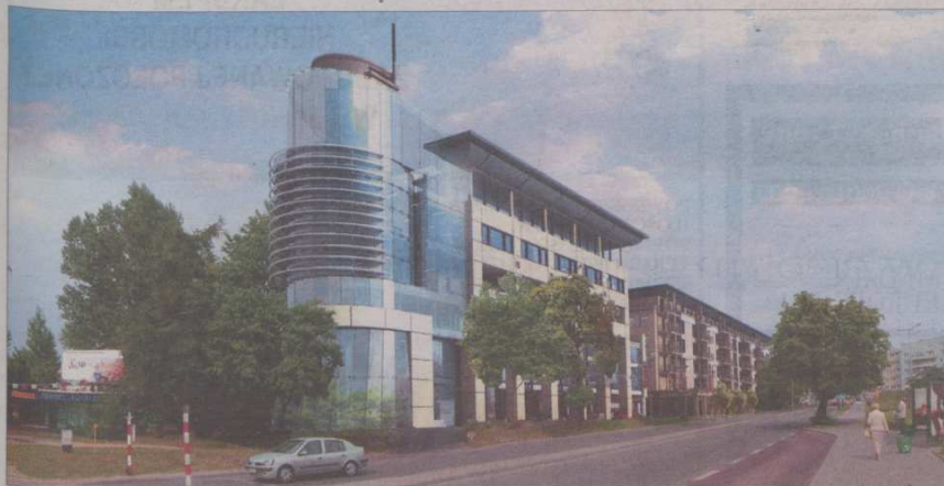
Firma Margo przygotowuje się do budowy kompleksu usługowo-mieszkalnego Baltic House w Redłowie. Architektura nawiązuje on do tradycji modernizmu gdynińskiego.
