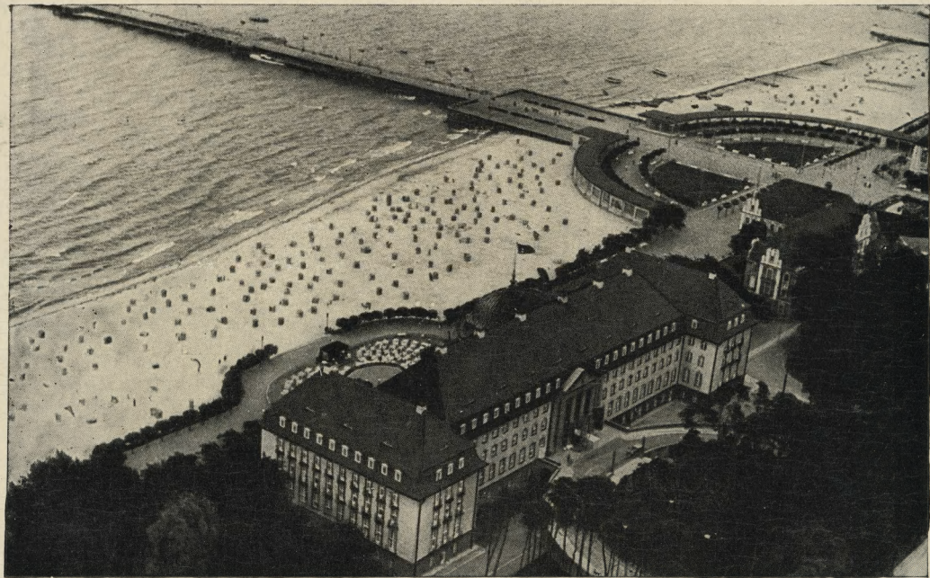
Zoppot: Luftaufnahme des Kasinohotels
