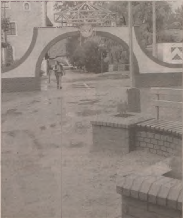
po dwóch miesiącach zwłoki, ruszyła budowa ścieżek rowerowych w Parku kultury i Wypoczynku. Prace mają się zakończyć za miesiąc.
