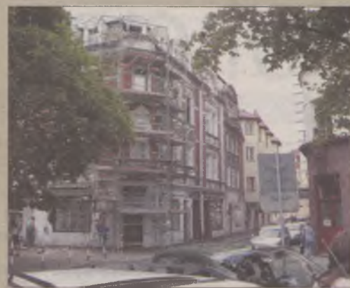
Kolejna kamienica doczekała się remontu, tym razem budynek przy ulicy Filmowej.
