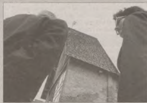
Dach Baszty Czarownic będzie wkrótce wyremontowany.
