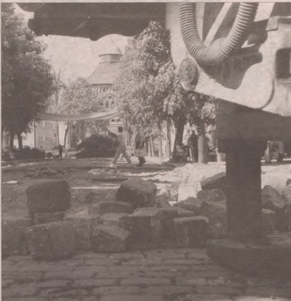
Na ulicy Nowobramskiej asfalt zostanie zastąpiony przez kamienną kostkę i płyty granitowe.
