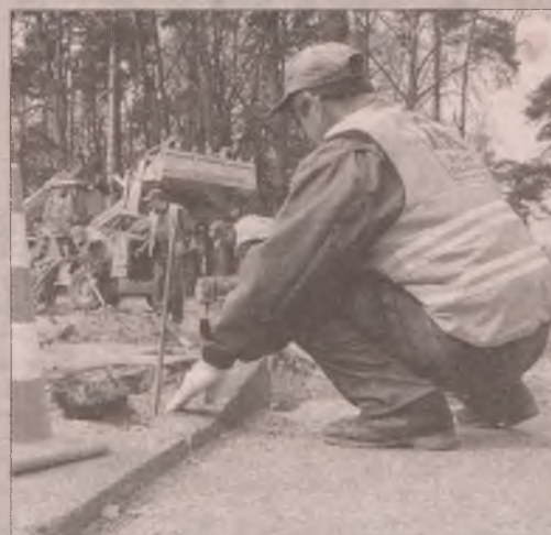
Remont ulicy Wróblewskiego zakończy się 30 kwietnia.
