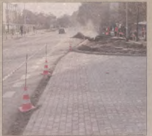
Remont ulicy Wróblewskiego zakończy się w kwietniu.
