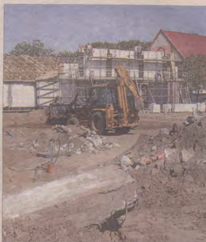
Urzędnicy walczą, a supermarket u zbiegu al. Grunwaldzkiej z ulicą Kościuszką jest już prawie gotowy. Fot. Grzegorz Mielbrung
