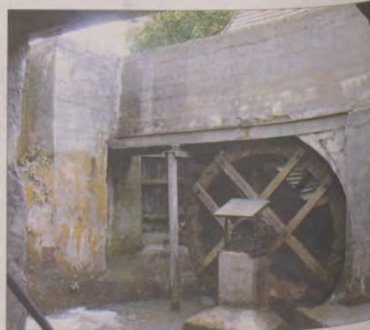
Koło ma średnicę 5,5 metra i 44 łopatki.
