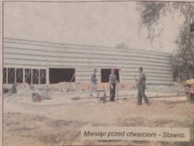
Prace wykończeniowe w nowo powstającym marketcie.
