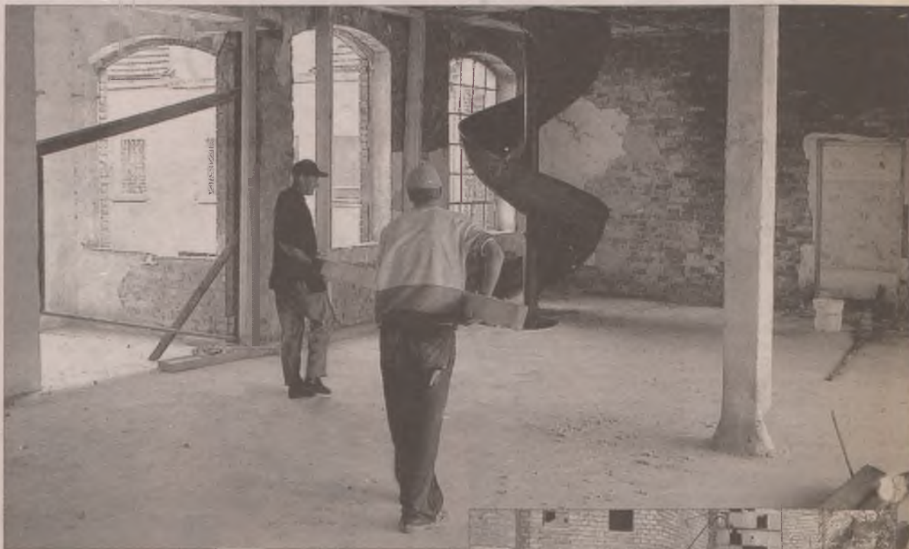
Modernizacja budynku po byłej Centrali Nasiennej będzie wykonywana etapami.
