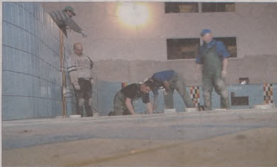
W ciągu najbliższych dni zakończone zostaną prace budowlane.
