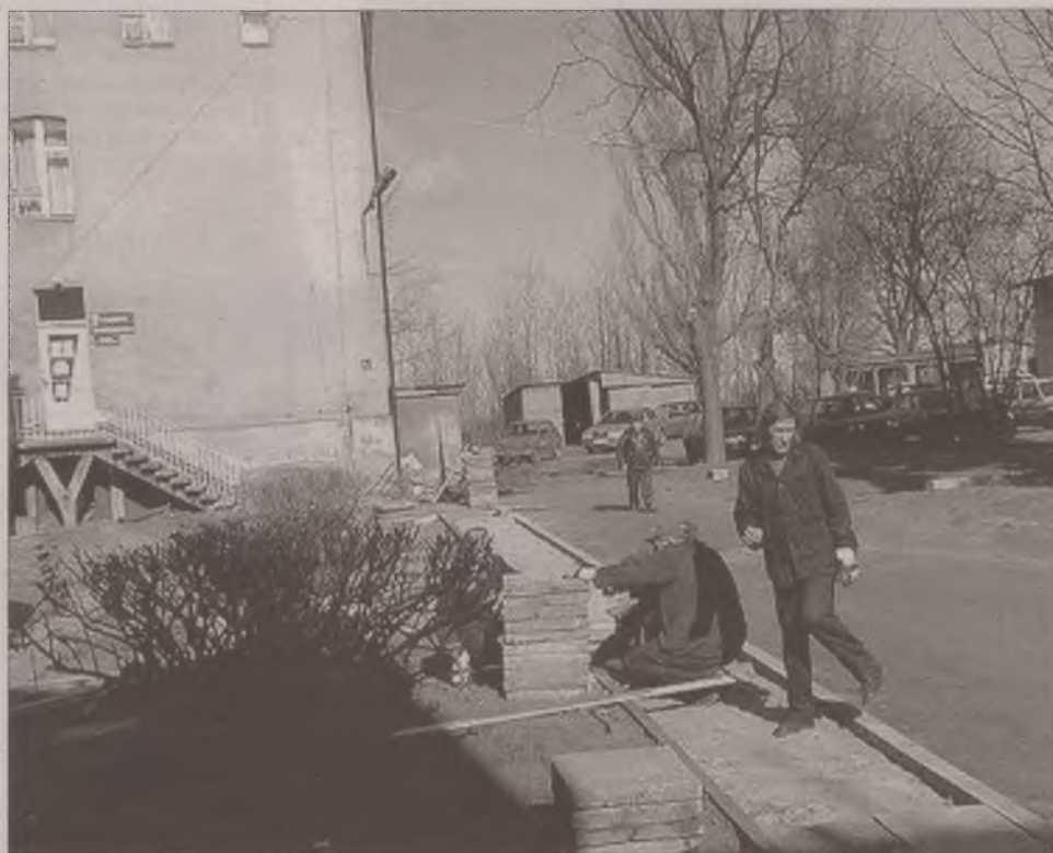
Prace remontowe w szpitalu zostały już rozpoczęte.
