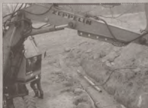
Jedną z gminnych inwestycji jest budowa kolektora sanitarnego.
