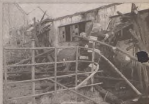
Pożar strawił doszczętnie górną część budynku, siano i słomę.
