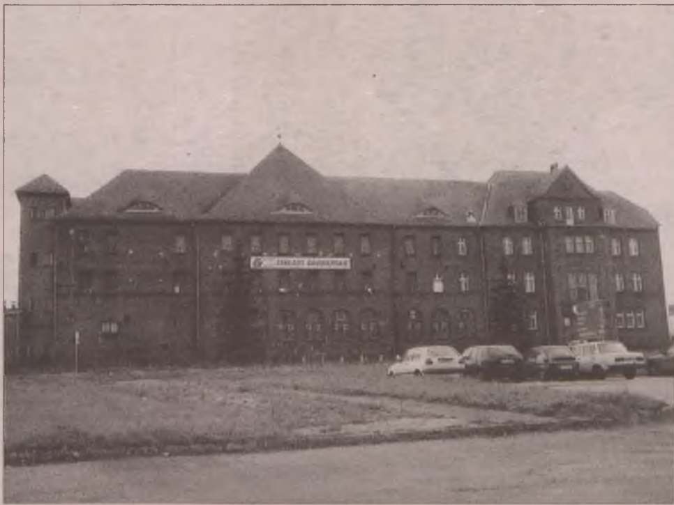
Nie wiadomo jeszcze, czy zabytkowy budynek Zakładów Drobiarskich zniknie z panoramy miasta.
