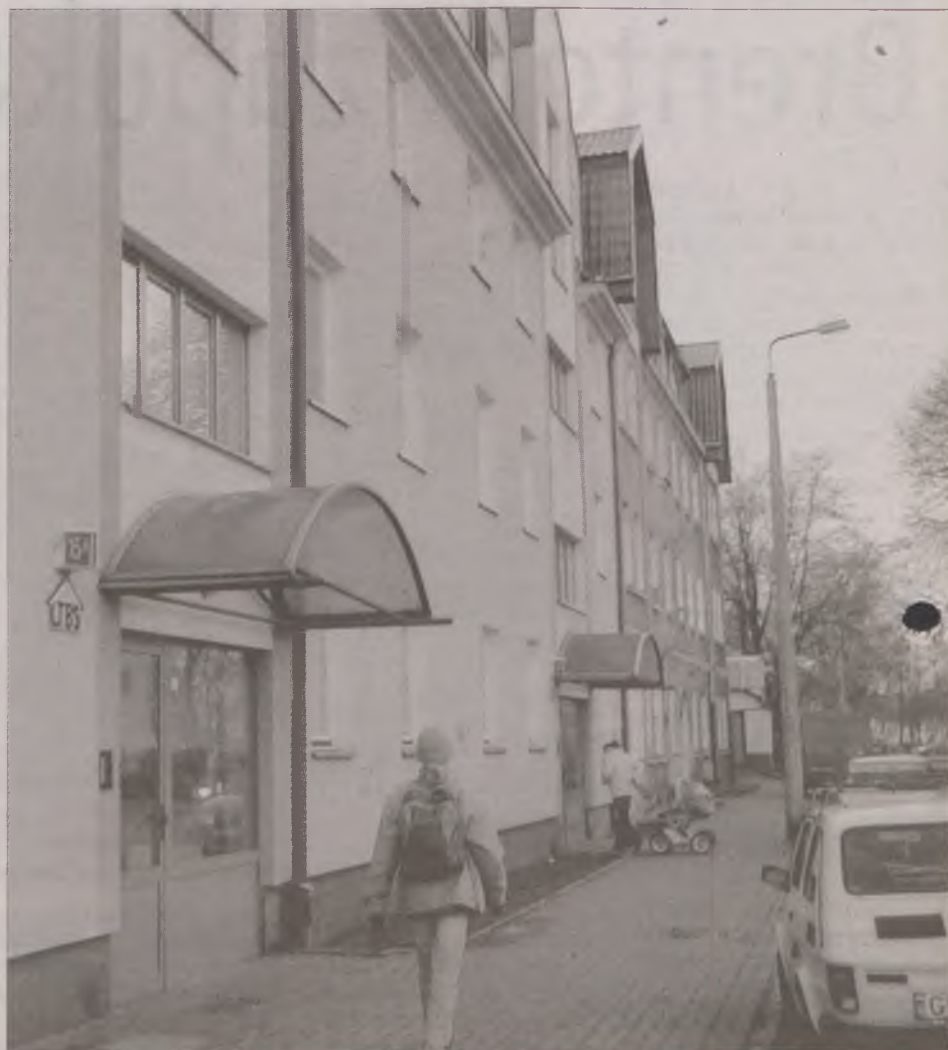
Budynek przy ul. Sienkiewicza był pierwszą inwestycją TBS.
