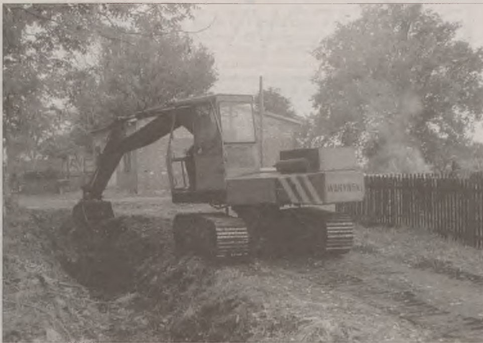
Prace przy budowie wodociągu potrwać w Żarnowskiej do końca września.
