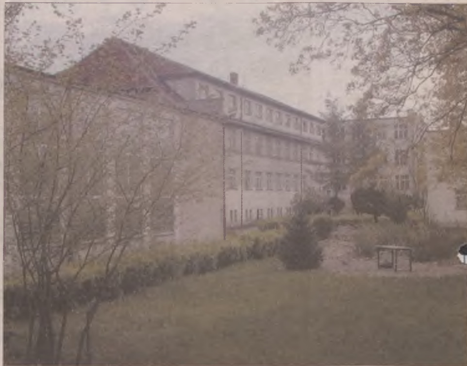
Budynek Zespołu Szkół Gospodarki Żywnościowej i Agrobiznesu został wybudowany w 1922 roku.
