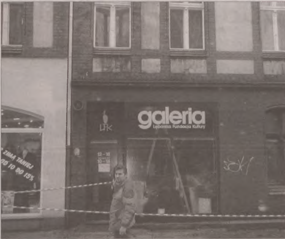
Z zewnątrz budynku nie ma śladów po pożarze.
