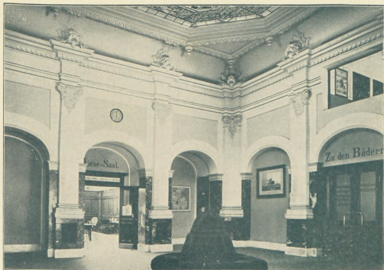
Wartehalle im Warmbad.
