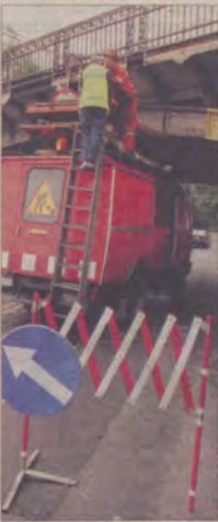
Naprawa zerwanej trakcji spowodowała zwołanie ulicy do jednego pasa.
