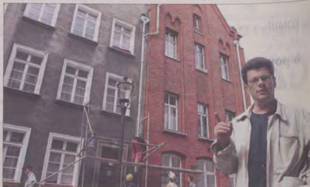
Restauracja unikatowej, neogotyckiej elewacji kamieniczki przy ul. Ogarnej 3 dobiega końca. Wykonawcą była Gdańska Pracownia Konserwatorska Barbary i Ludwika Brzuskiwiczów. Fot. Robert Kwasnik
