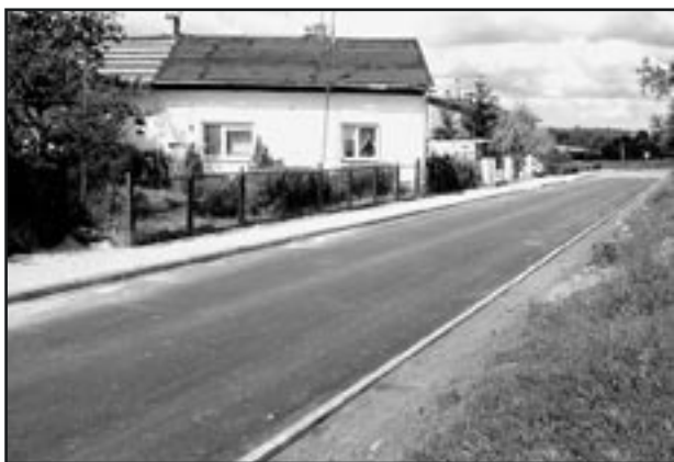
Nowa nawierzchnia na drodze w Bobrownikach
