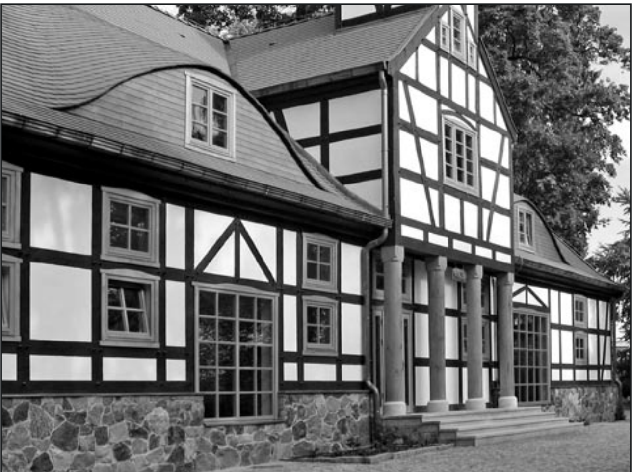
Wozownia po odrestaurowaniu
