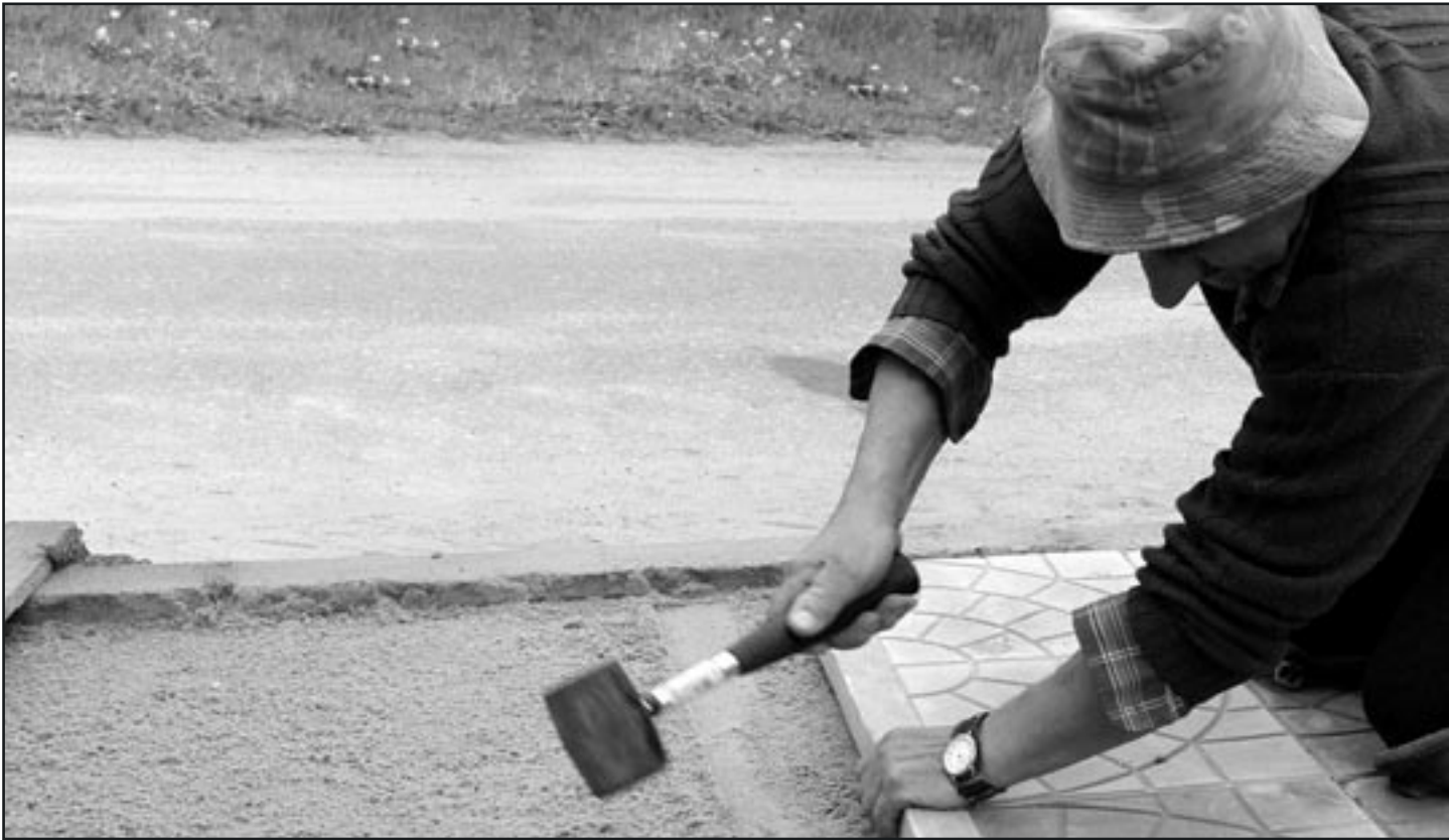
Prace interwencyjne na ulicy Skarszewskiej w Dębnicy Kaszubskiej
