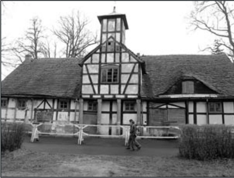
Stara Wozownia w Warcinie - przed odrestaurowaniem
