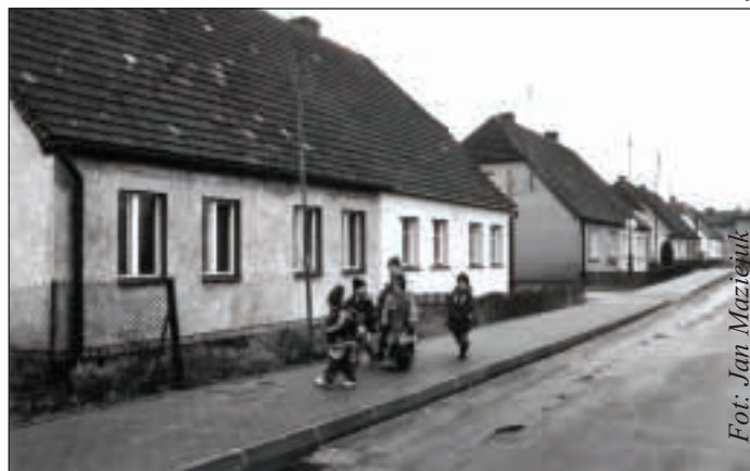
W Warcinie, przy całej długości głównej ulicy wybudowano nowe chodniki
