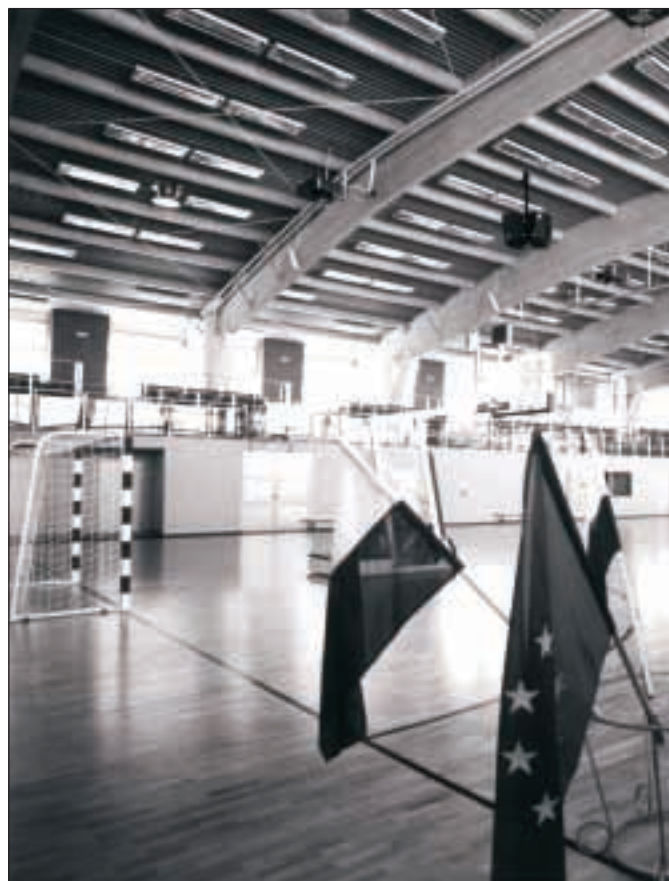
Dźwigary z drewna klejonego przypominają aerodynamiczny profil skrzydła samolotu Zdjęcia: Jan Maziejuk
