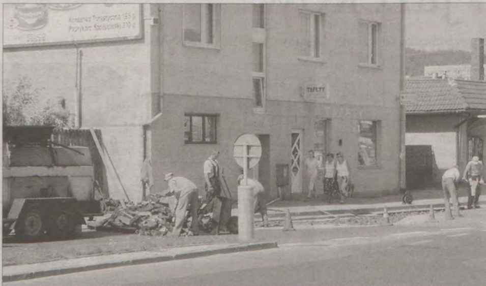
Pracownicy PUK w Rumi wyremontowali odcinek ul. Dąbrowskiego przy posesji nr 24.
