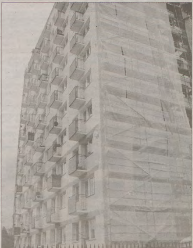
Wieżowiec przy ul. Abrahama 7 został docieplony.
