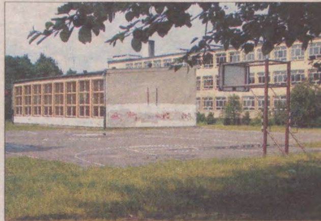
Basen zostanie zbudowany przy Gimnazjum nr 1 w Rumi.
