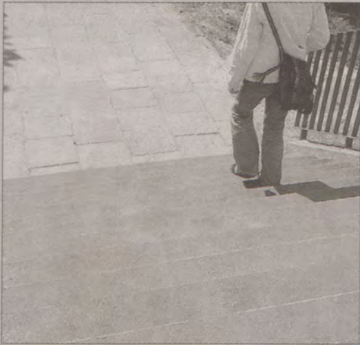
Schody zostały naprawione.
